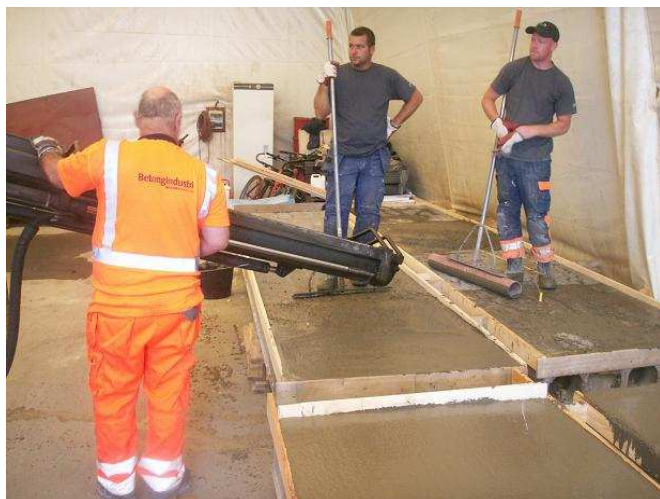
Figur 7 – Pågjutning på håldäckselement i Kålleröd 2009.
