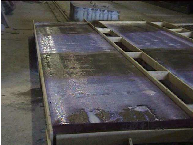
Figur 14 – En del av HD-/F-elementen i Nykvarn behandlades med vatten eller primer så att viss pölbildning kvarstod vid pågjutning.
