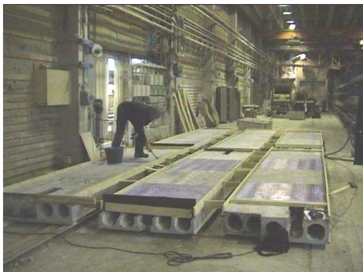
Figur 8 – Förbehandling av håldäckselement före pågjutning i Nykvarn 2010.
